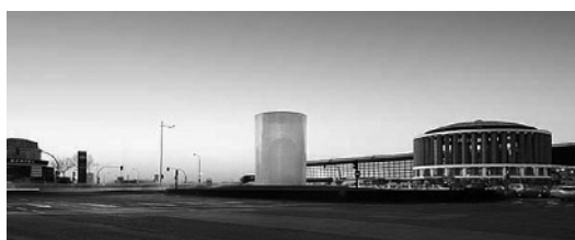
Figura 08. Estudio FAM. Monumento a las víctimas del 11M, Madrid, 2005. Fotografía una vez construido.
